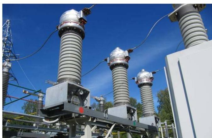
Рис. 1. Трёхфазная группа измерительных трансформаторов тока серии ТРГ на основании из металлоконструкций на ОРУ-110 кВ ПС
