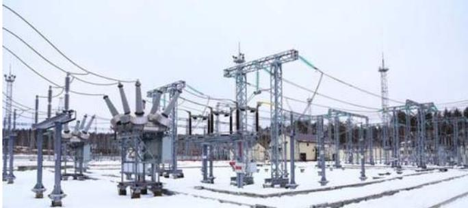
Рис. 3. ОРУ 110 кВ блочной ПС 110 кВ
