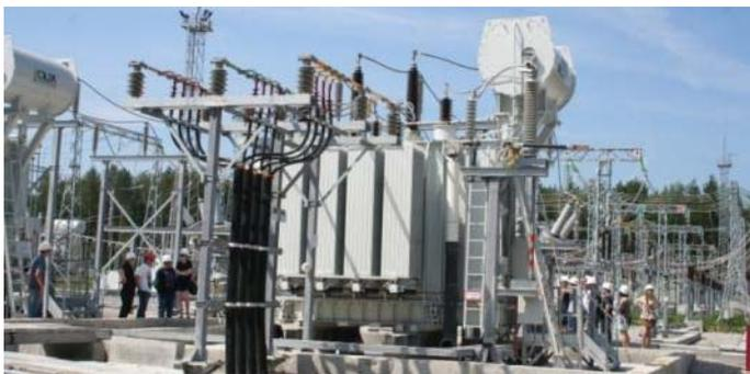
Рис. 4. Трансформатор 110/20 кВ 40 МВА блочной ПС
