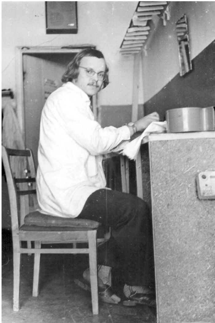
Чистка вентилятора накопителя на магнитной ленте. Вычислительный центр гидрометеоцентра, 1978 год
