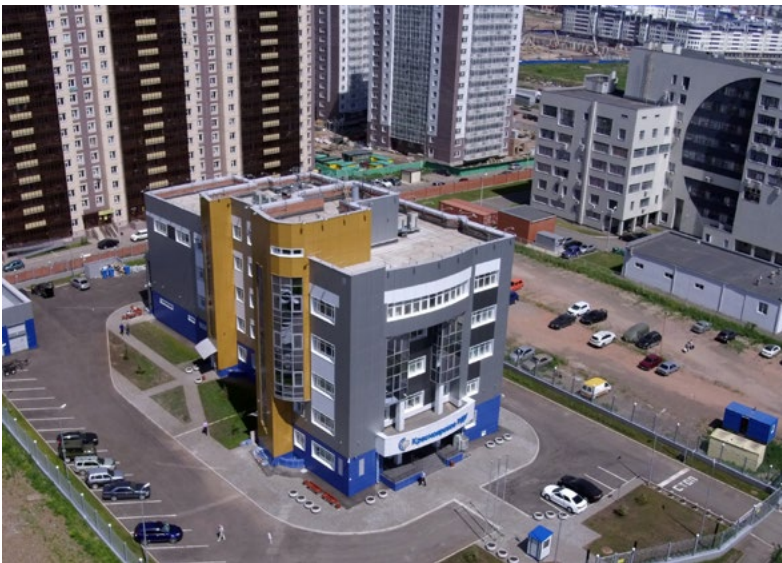
Здание Красноярского РДУ
