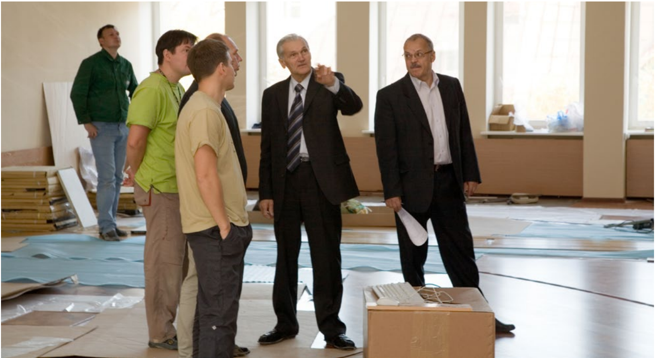
На строительстве диспетчерского зала ОДУ Востока, 2009 год
