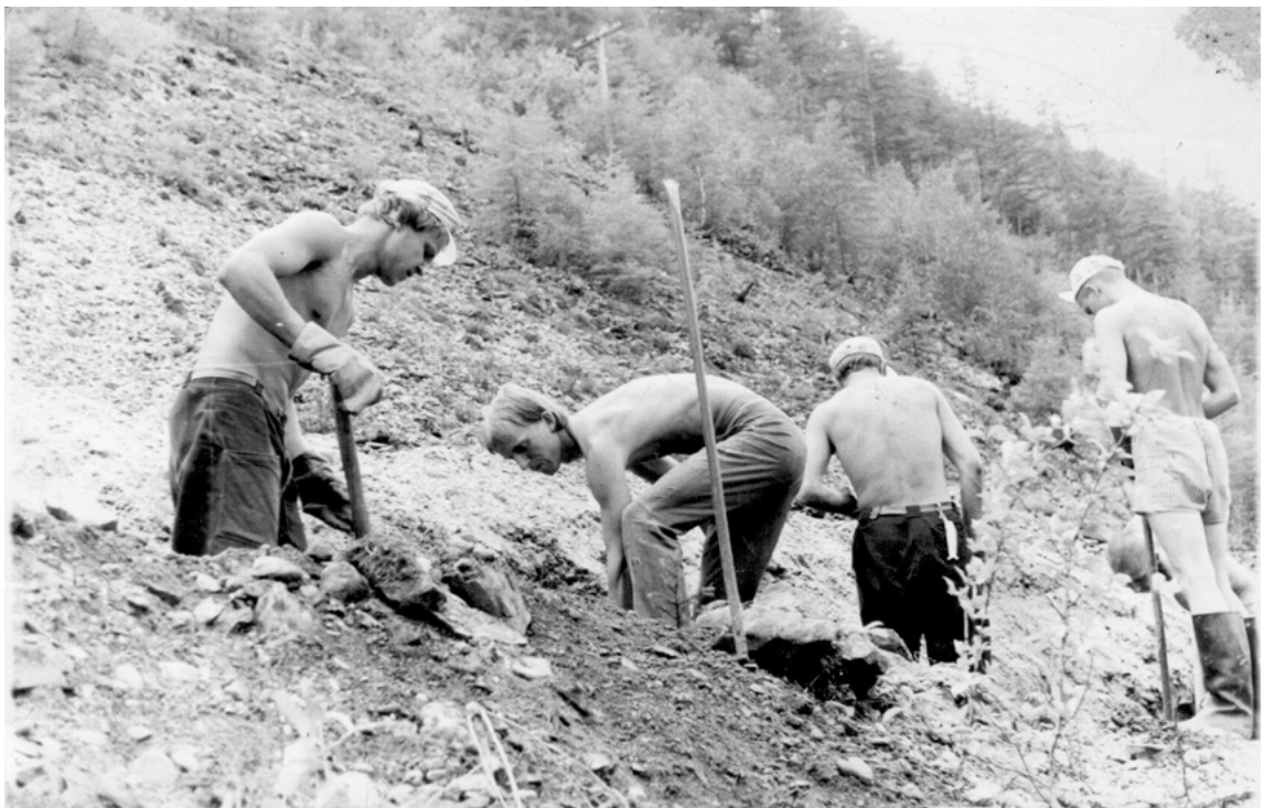
Стройотряд, работы по прокладке кабеля, 1975 год
